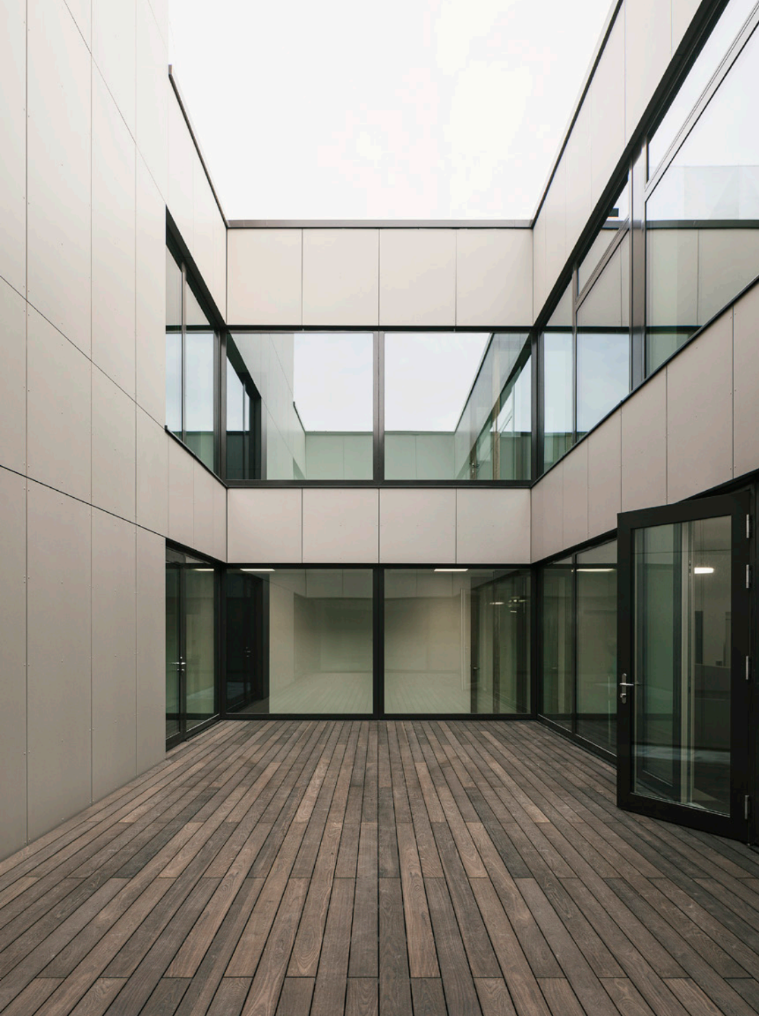
Die Lichthöfe dienen als Außenklassenzimmer
