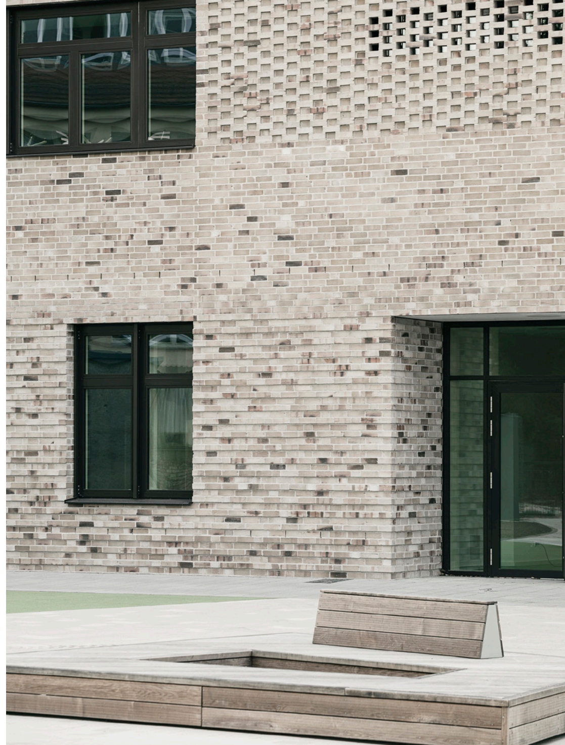
Gebäude und Freianlagen als symbiotische Einheit
