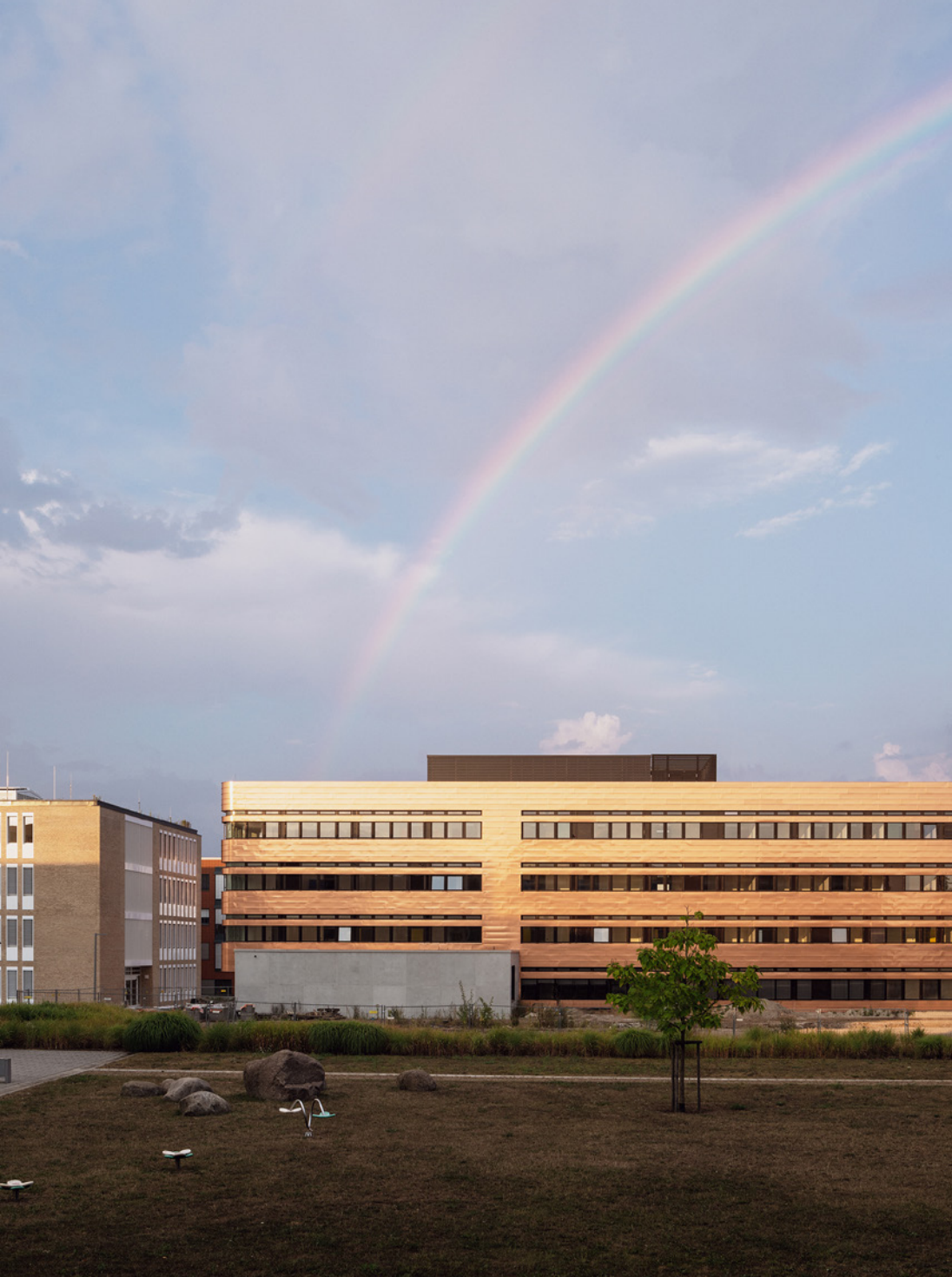
Die Fassade aus „coated“ Kupfer verleiht dem Gebäude im wahrsten Sinne seinen besonderen Glanz.
