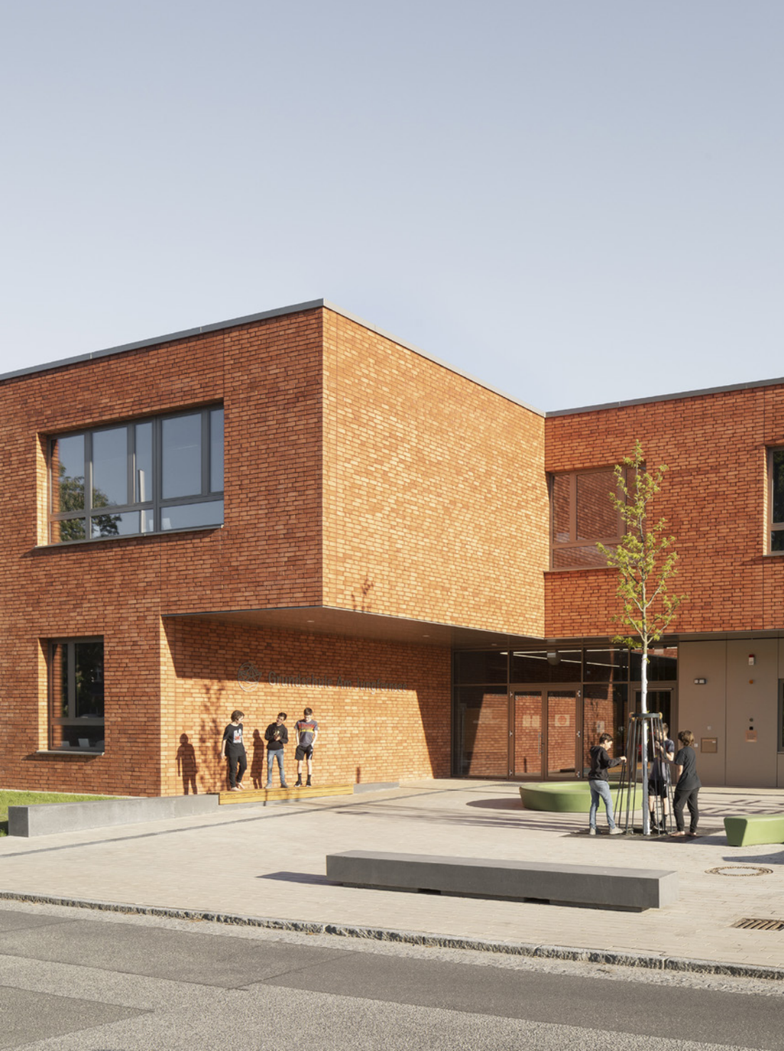
Wenn schon rot, dann richtig. Das Rot der Klinkerfassade aus einem Wasserstrichklinker mit unregelmäßiger Oberflächenstruktur wird durch roten Fugenmörtel überhöht.
