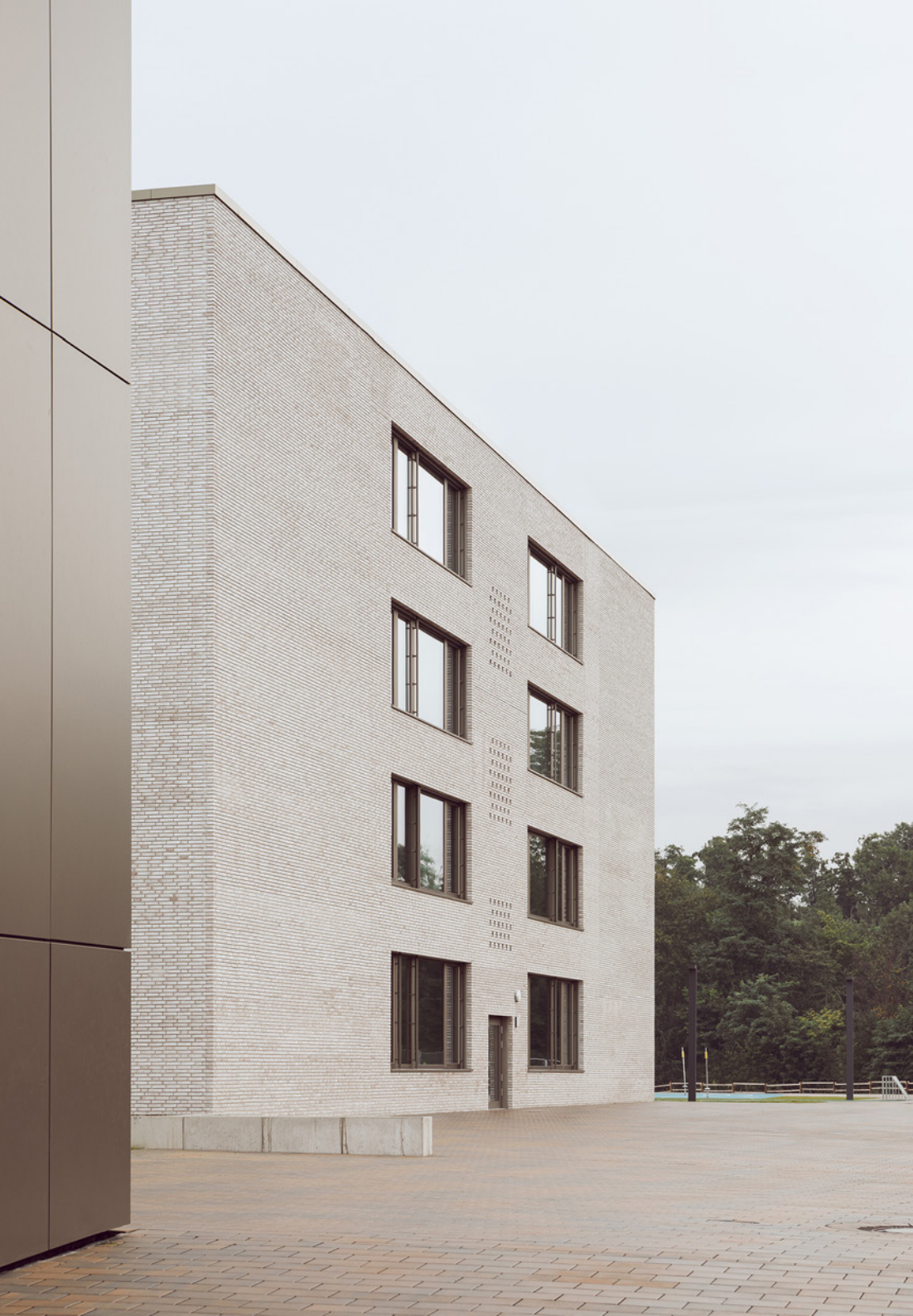
Der Neubau erhält eine robuste Mauerwerksfassade aus hellem, geschlammtem Klinker, der als einheitliches Kleid die Baumassen beruhigend zusammenfasst.
