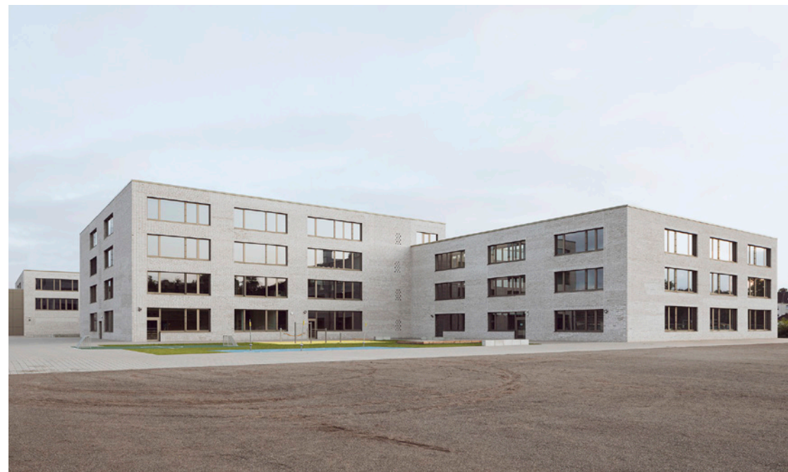
Der Neubau erhält eine robuste Mauerwerksfassade aus hellem, geschlammtem Klinker, der als einheitliches Kleid die Baumassen beruhigend zusammenfasst.
